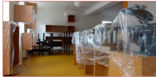
Renovierung im Bibelzentrum Wuppertal / Foto: EBR
